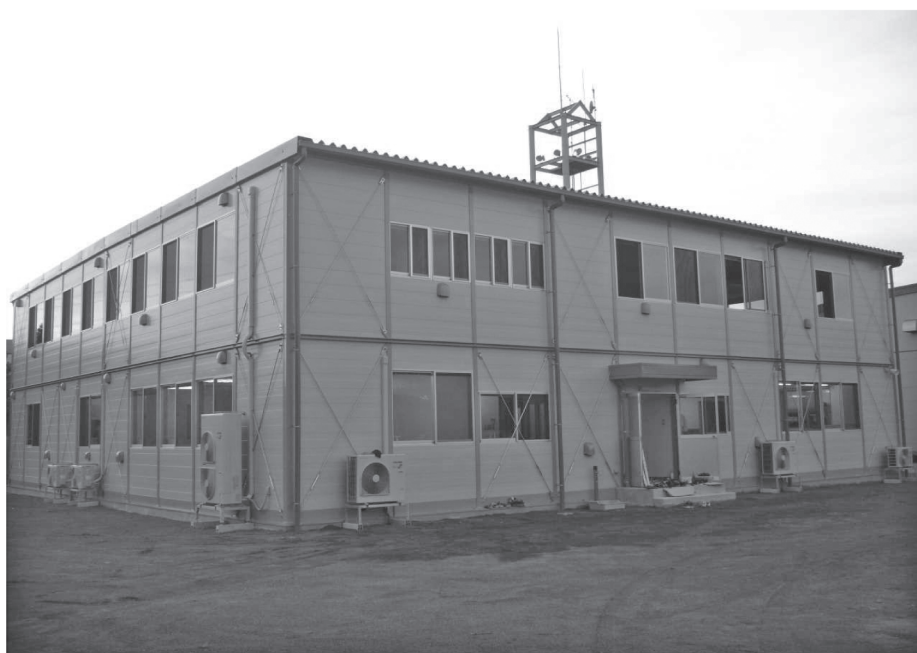
双葉消防本部仮庁舎 平成24年9月28日竣工
